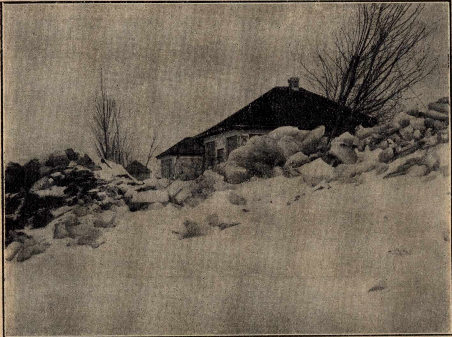
Szél okozta jégtorlódás veszélyezteti a partvédműnélküli villát.
