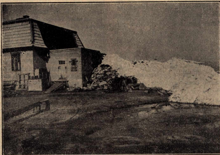
Hullám és jégtorlódás által összerombolt villa.
