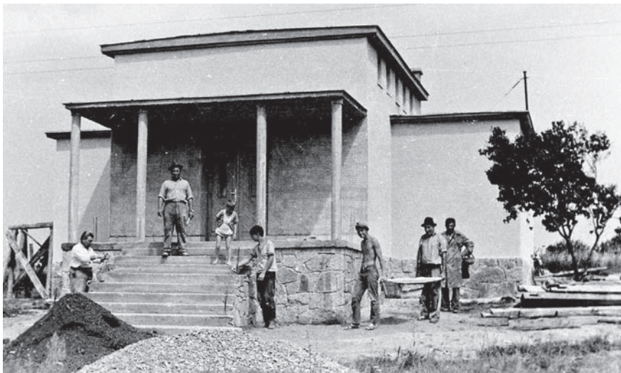
A ravatalozó építése
