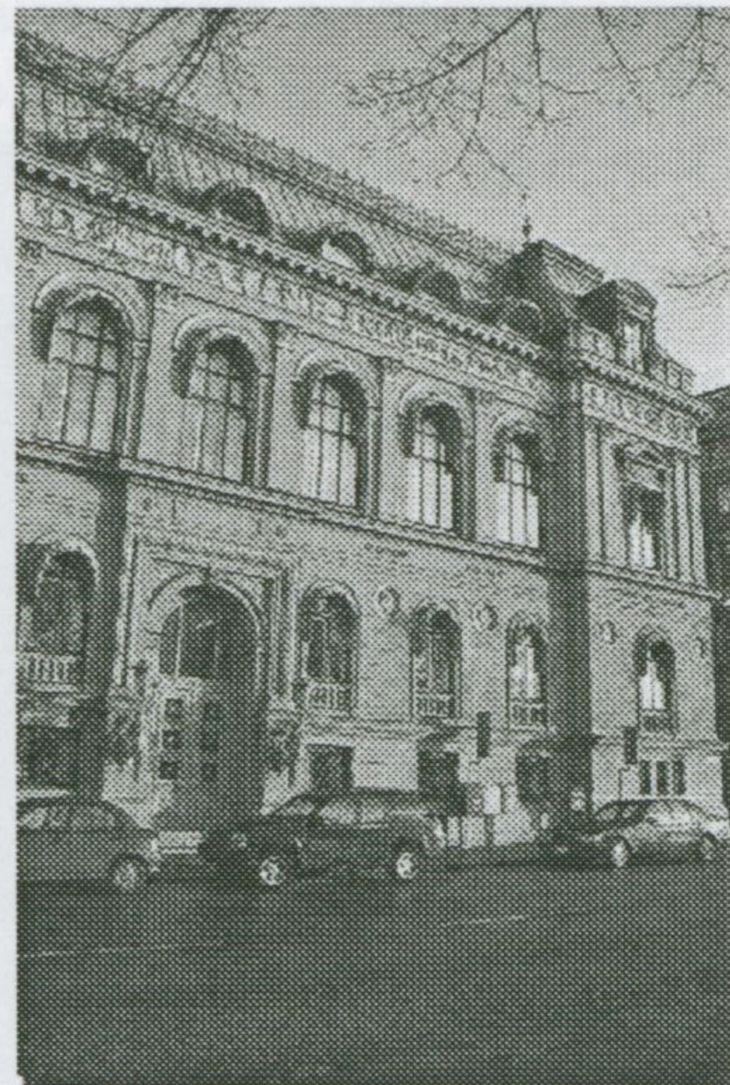
A Järnkontoret épülete
