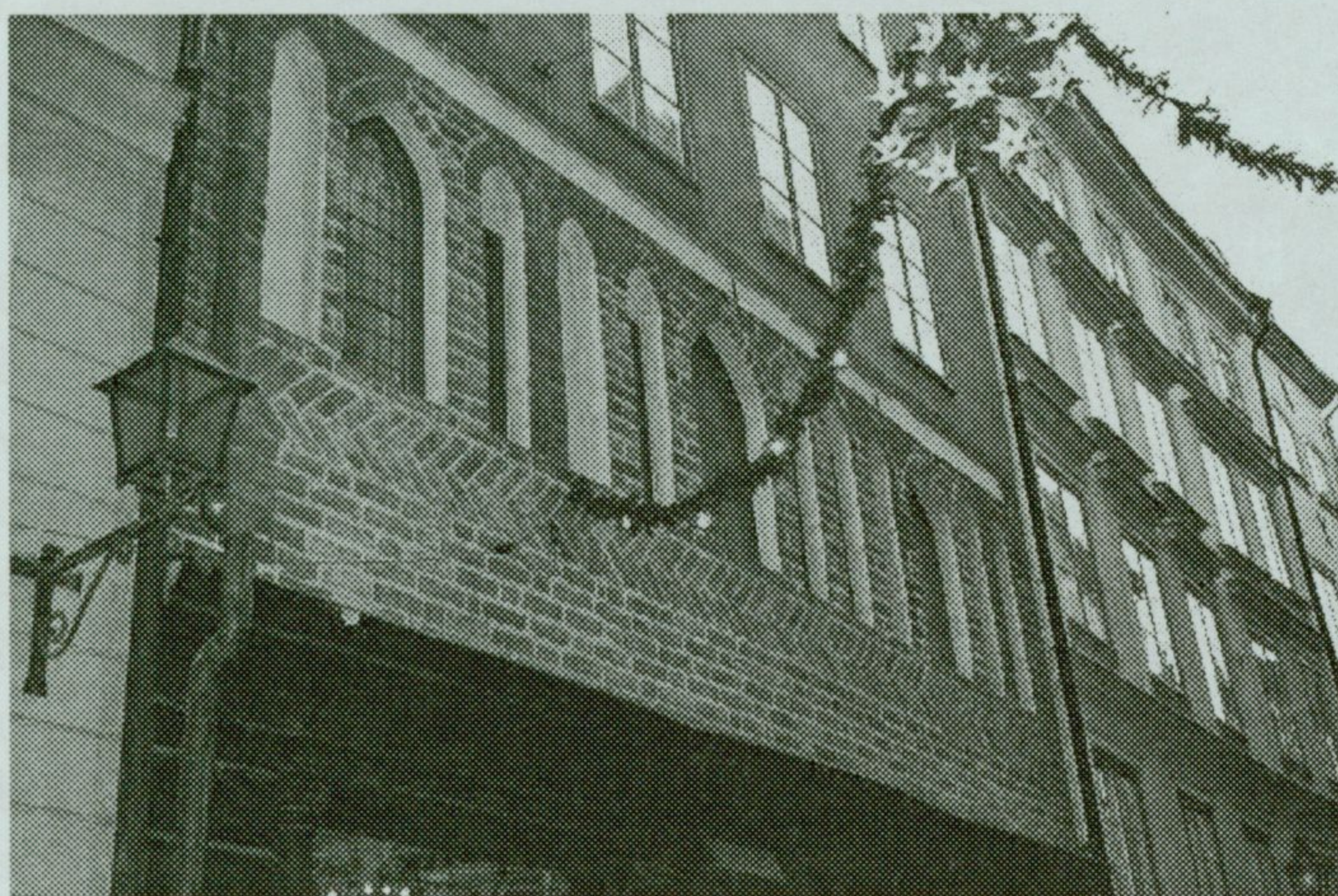
Västerlånggatan 29. Gótikus ablakok a középkorból
