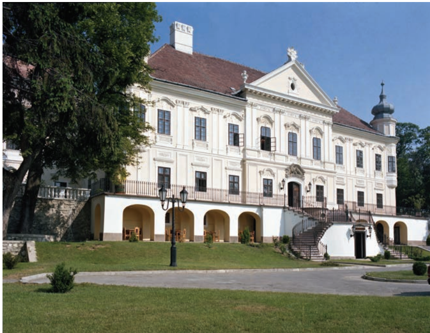
A helyreállított épület az új kétkarú lépcsővel
