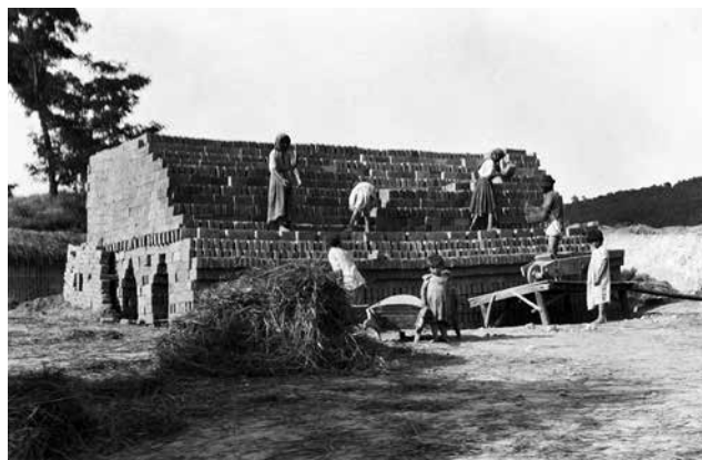
Téglavető cigányok az égetőkemencét építik, Piliny, 1910. Nyáry Albert felvétele
